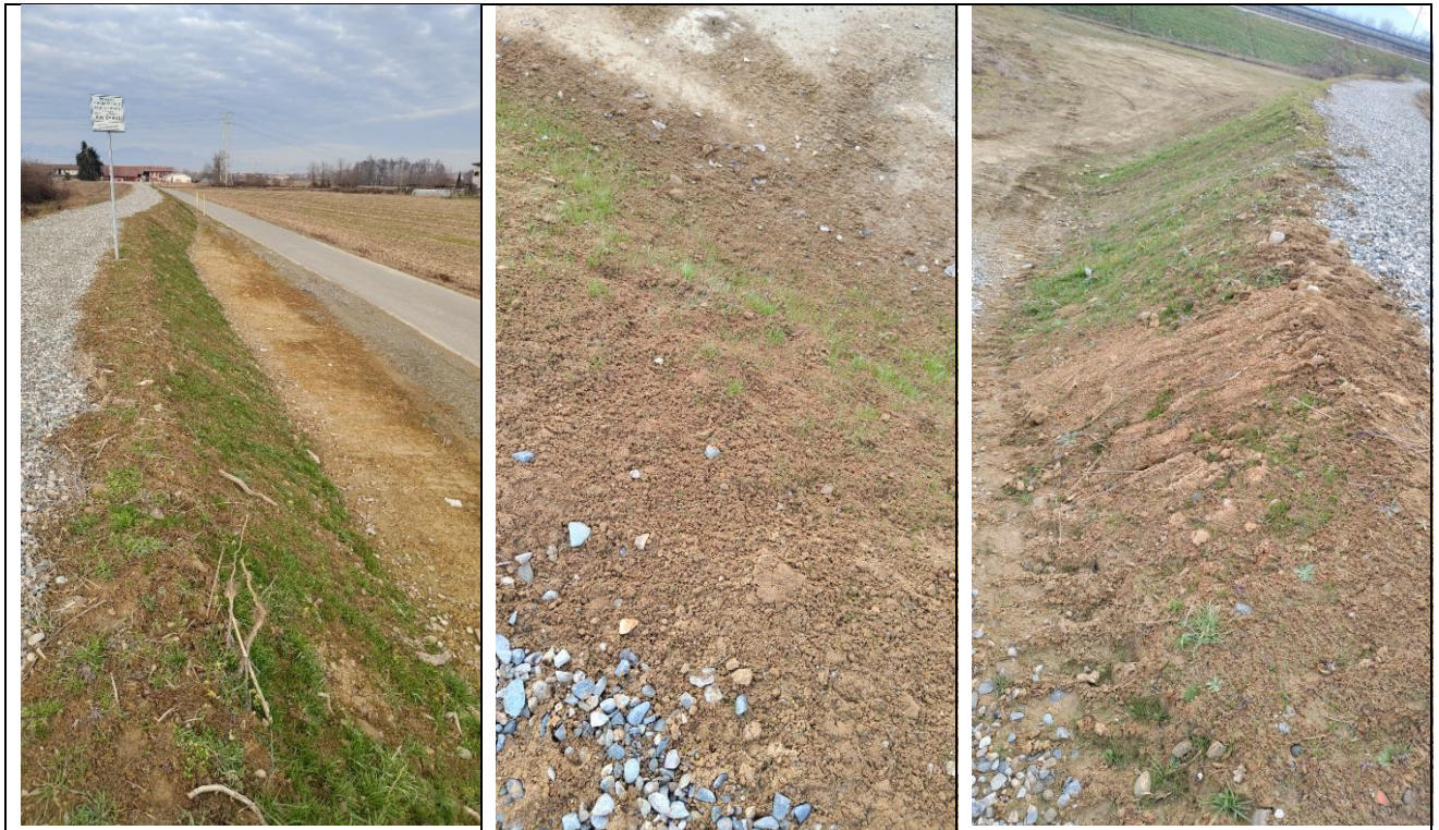
Fotografia 13 – Dettaglio degli interventi di inerbimento in fase di attecchimento. Foto del 15.12.2025.
