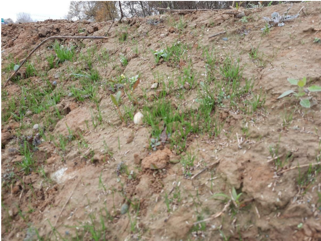
Fotografia 11 – Dettaglio dell'inerbimento e della semina sul rilevato arginale. Foto del 18.11.2025.
